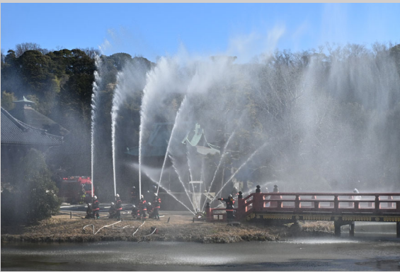
文化財防火デーでの放水訓練 (1月)
