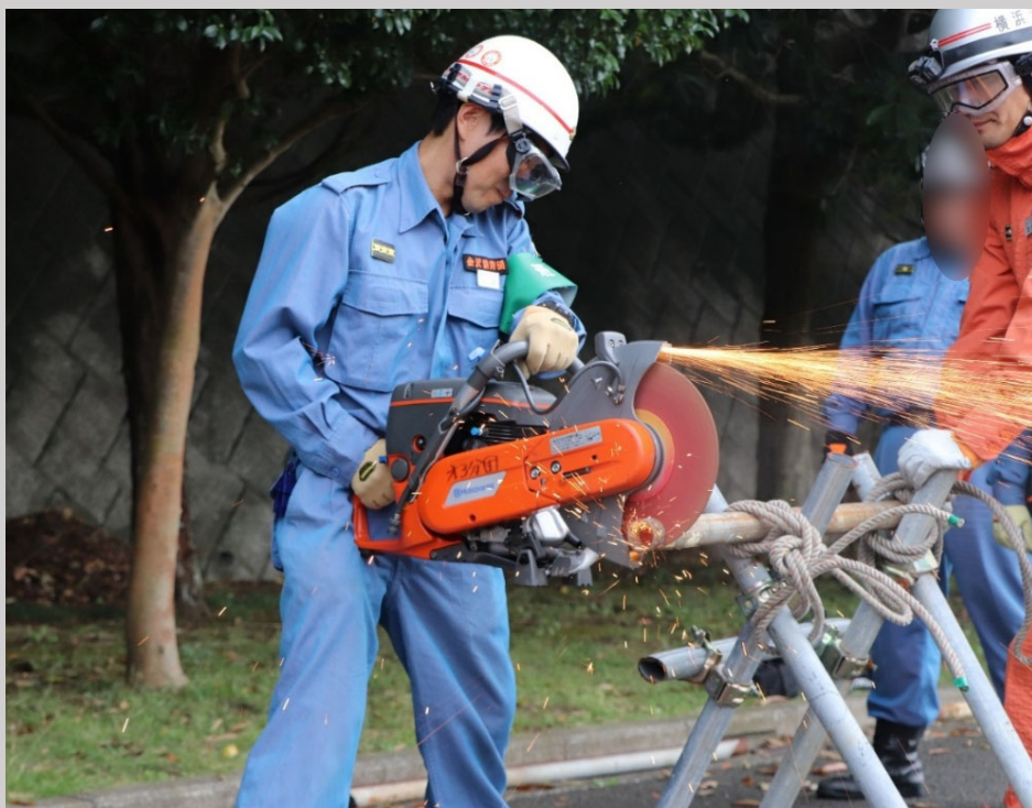
資機材取扱訓練(10月)
