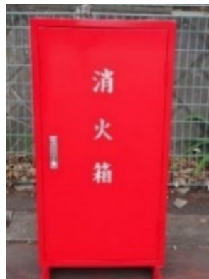
初期消火箱（固定式）
